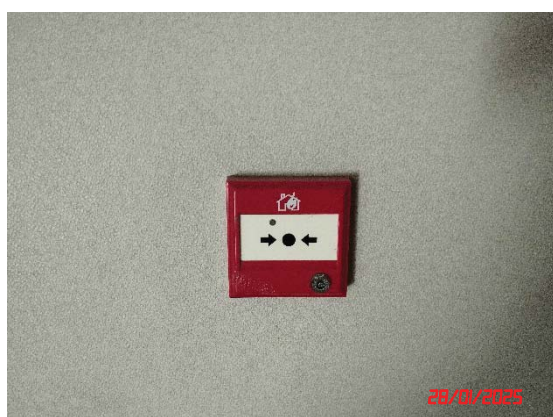
ระบบแจ้งเหตุฉุกเฉินแบบใช้มือกด
